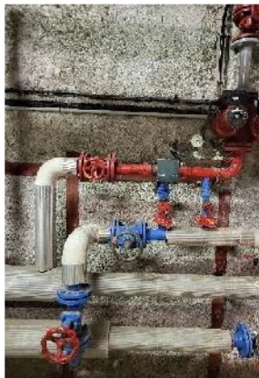
Arrivée du primaire en sous-station
