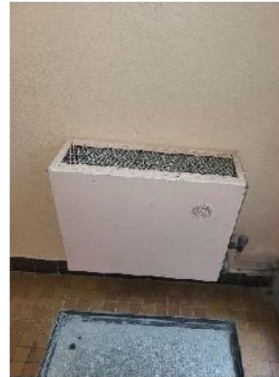
Terminaux de chauffage (obsolètes)
