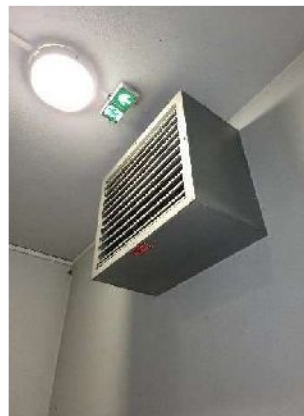
Terminaux de chauffage (obsolètes)
