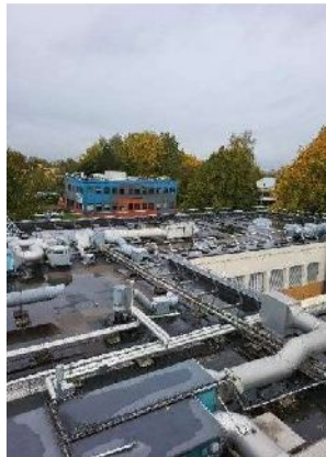
CTA en toiture et réseaux de gaines
