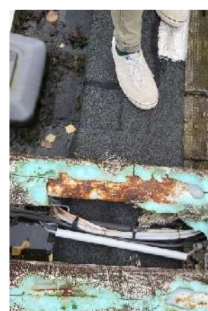
Dégradations réseau de chauffage
